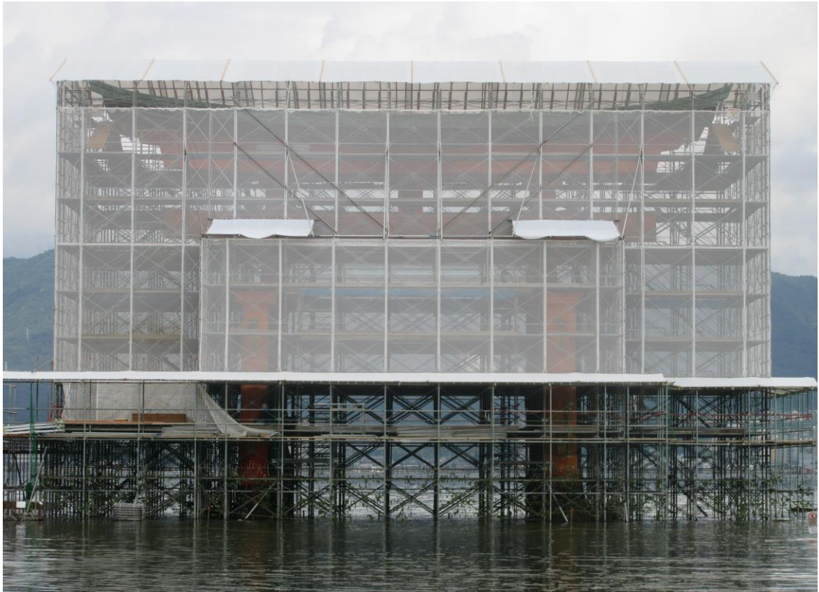
9.0 4 (水) 午前9時頃 正面 より撮影
