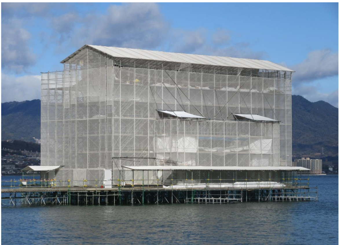
1.29(水) 午前11時頃 西松原 より撮影
