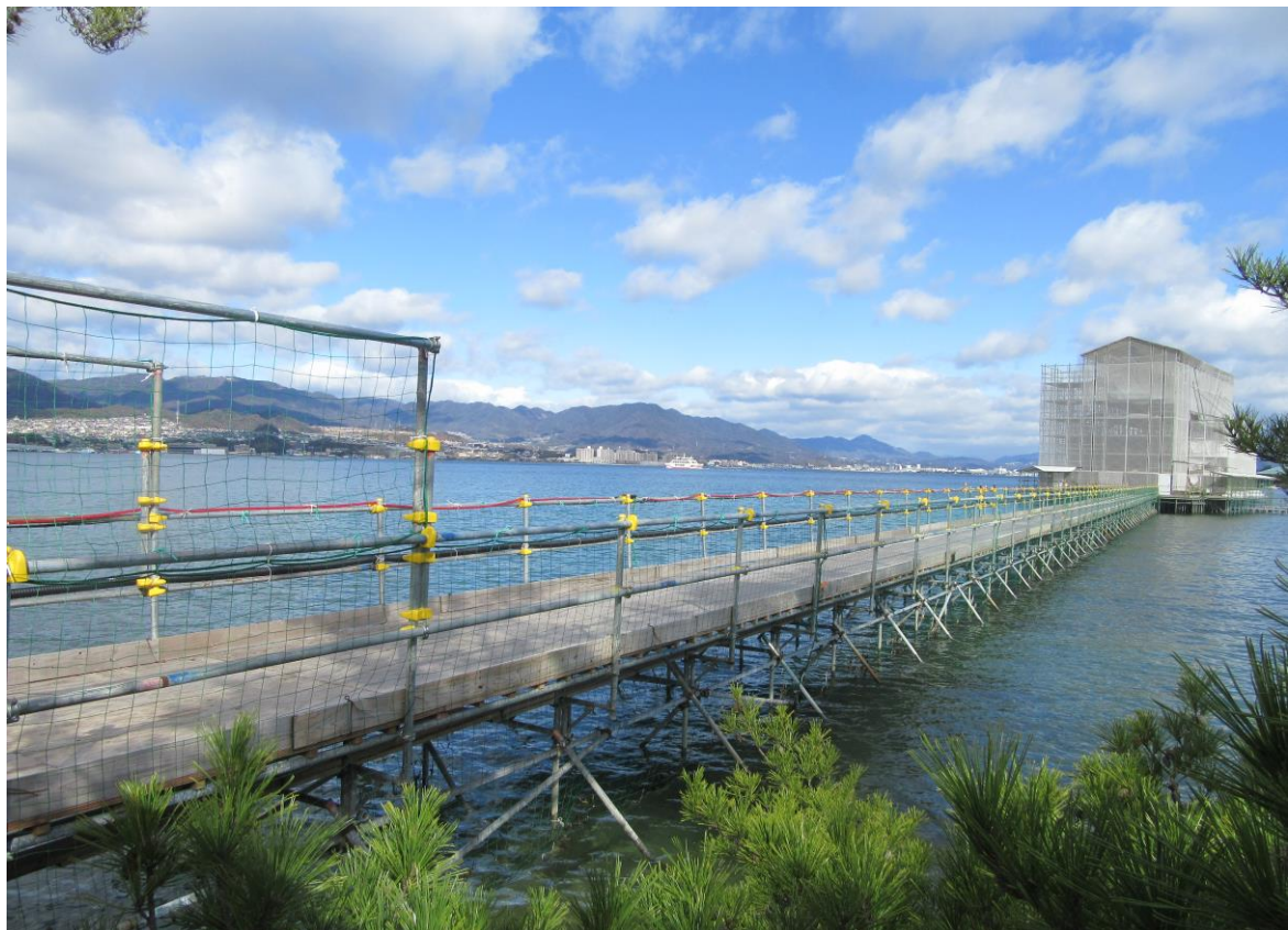
1.29(水) 午前11時頃 西松原(仮設栈橋入口付近)より撮影
