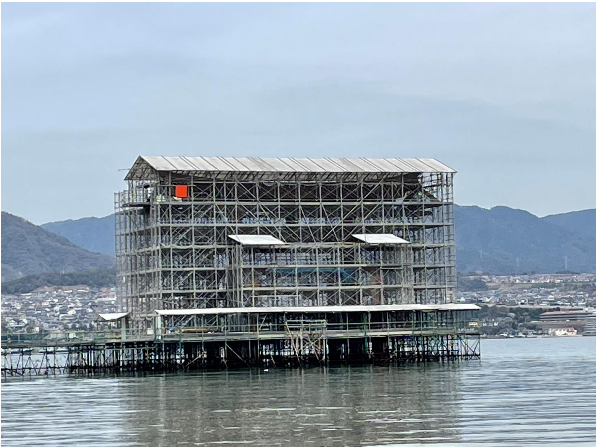
2022.3.29(火) 午前10時頃 鳥居正面 より撮影
